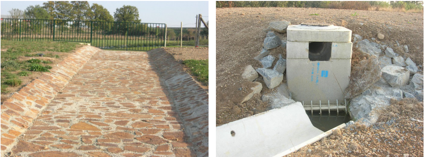
Figure 26 : Exemple de surverse par seuil
